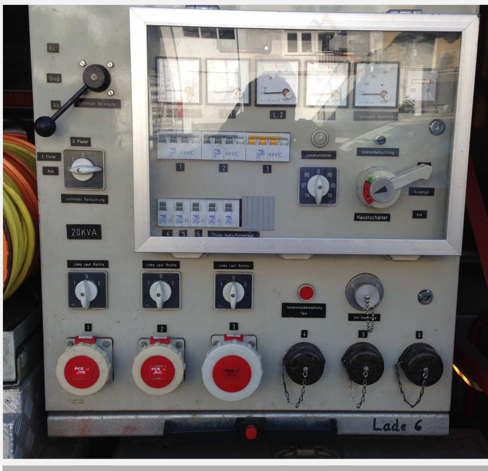
Hitinger 20 KV Stromaggregat im Aufbau mit Schaltverteiler und Steuerungskasten
